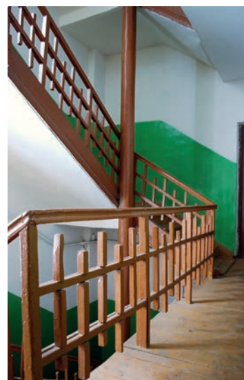
Рисунок 7 – Лестница в жилом доме по ул. Мичурина в Горках
