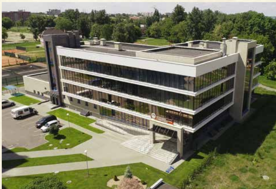
Здание Брестского агентства (г. Брест, ул. Гоголя, 2В)
